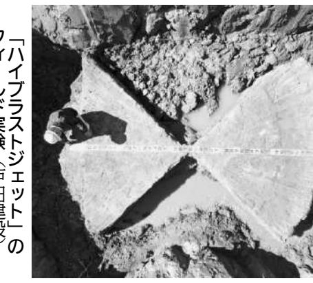
「ハイブラスジェット」のフィールド実験（戸田建設）
