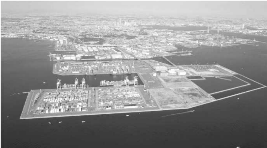
国内最大級の南本牧ふ頭コンテナターミナル（横浜市港湾局提供）
