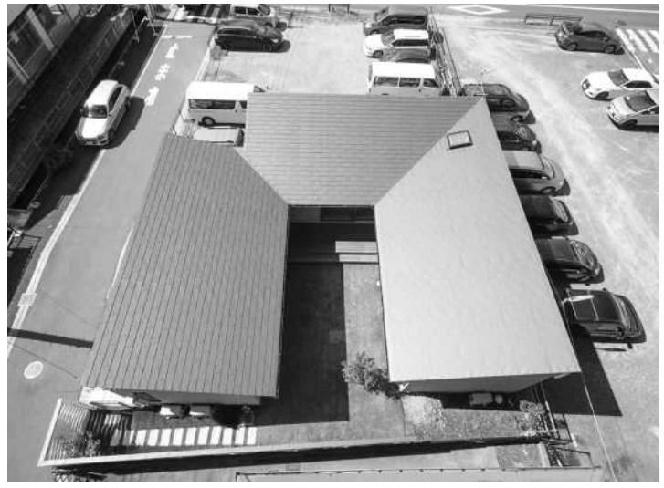
【写真1】「中庭のある家」都市部の住宅街に建つコの字型の平屋（写真＝小川重雄）
