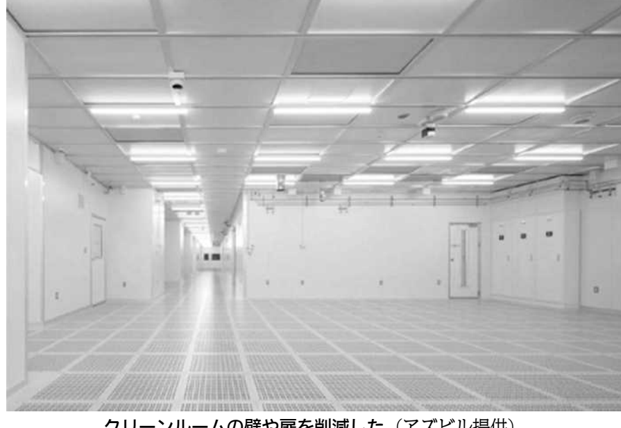
クリーンルームの壁や扉を削減した (アズビル提供)
