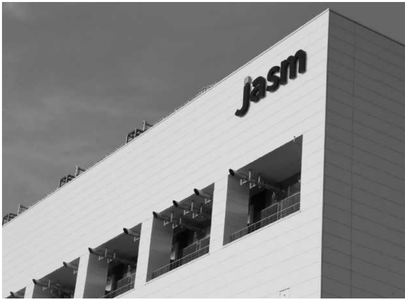
JASMは27年未だに第二工場の建設および稼働開始を目指す
