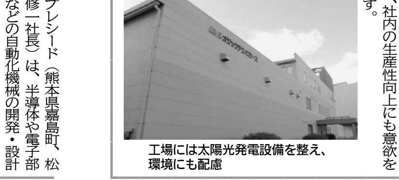
工場には太陽光発電設備を整え、環境にも配慮
