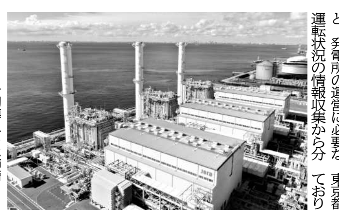
DPPを導入した姉崎火力発電所
