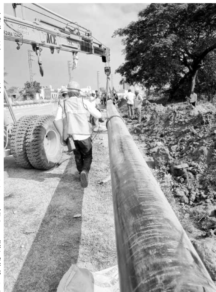
インドの導管敷設現場(大阪ガス)
