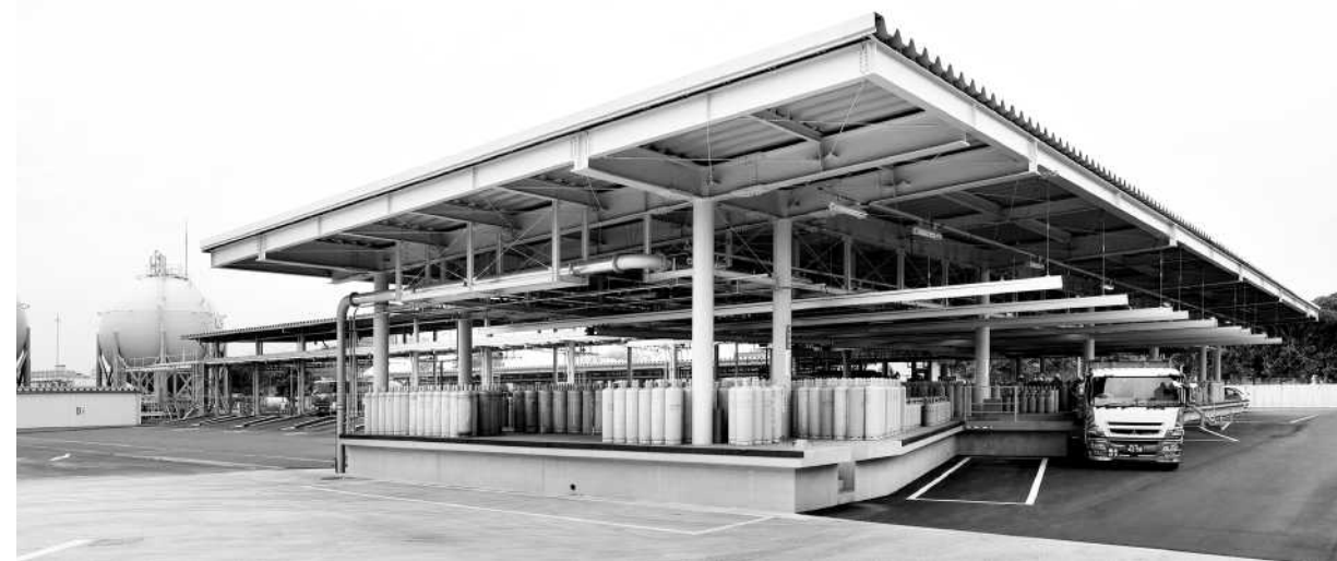
根岸液化ガスターミナル(横浜市磯子区)内に新設したLPGシリンダー充填所(岩谷産業)
