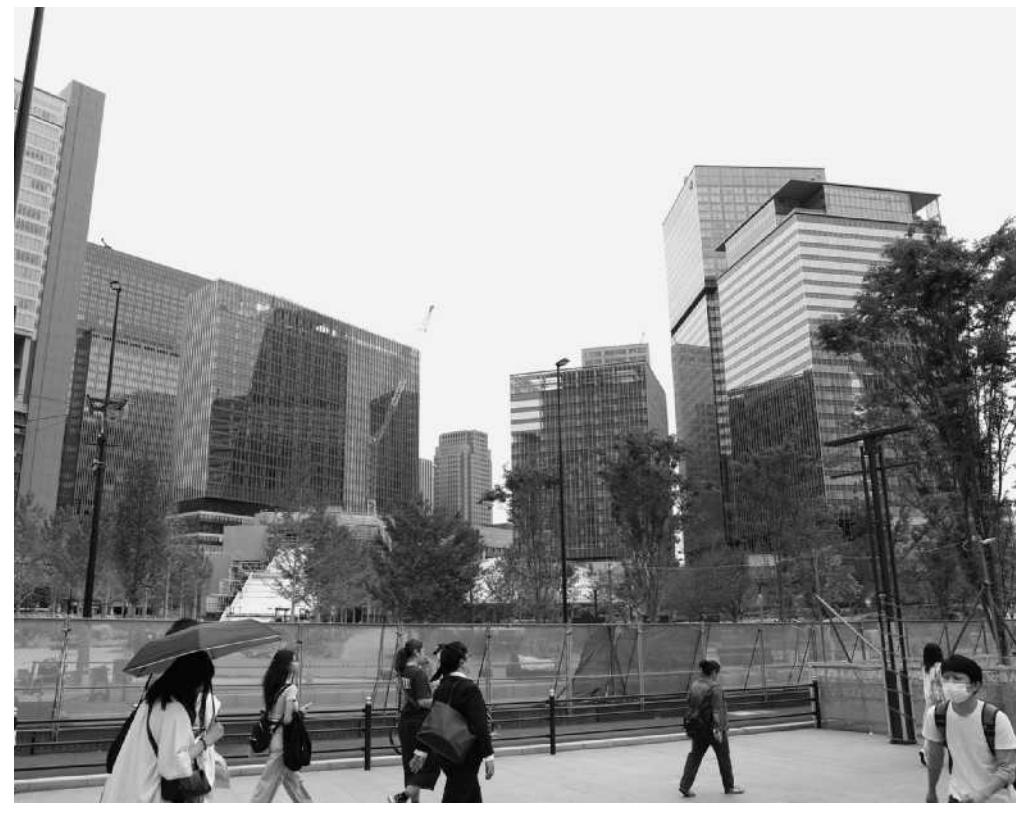
9月の先行まちびらきに向け、工事が急ピッチで進む「グラングリーン大阪」
