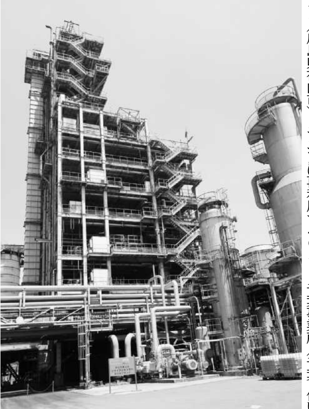
レソナックは川崎事業所で廃プラを原料に水素やアンモニアを製造する(廃プラのガス化プラント)
