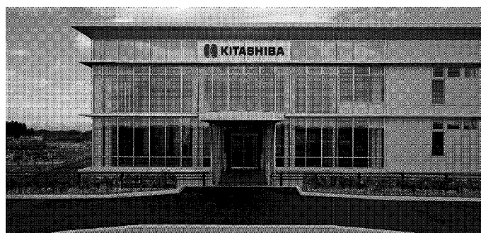
北芝電機の本社・変圧器技術開発センター外観
