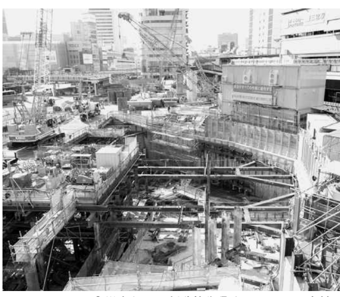
④災害からの創造的復興をテーマに国内外の機関が一堂に集まった「創造的復興サミット」の実施などを受け、斎藤元彦知事は25年の1字に「創」を選んだ ⑤神戸・三宮地区では順調に再開発事業が進む
