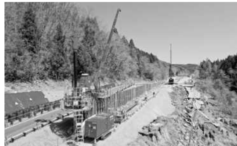
能登半島の復興で活躍する「サイレントバイラー」
