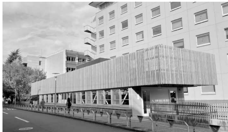
木材組み立て加工・デジタル加工機器などを設置した建築ものづくり工房 (横浜キャンパス31号館)
