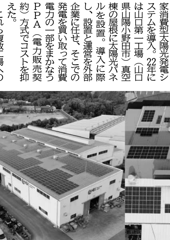
拠点への太陽光パネル設置を進める。上空から見た山口第一工場（右）と三重県のオーネックスセンター（左）
