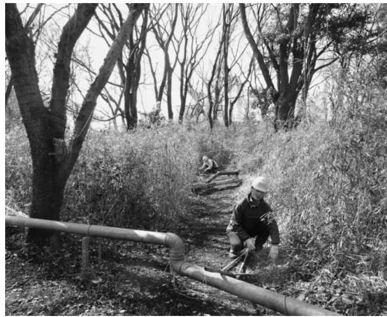
サギ山に散策路を整備し、地表面の明るさを確保する
