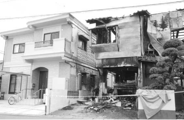
【写真3】2024年1月1日の能登半島地震で、隣家が全壊するも壁の修繕だけで済んだWPC工法の住宅
