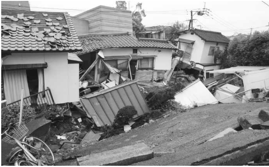
【写真1】熊本地震で震度7が2度襲った益城町(ましきまち)。旧耐震基準以前の木造住宅の多くが倒壊していた
