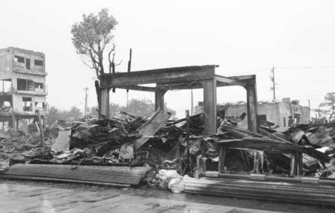
【写真2】輪島市朝市火災現場(2024年1月1日撮影)の倒壊した建物
