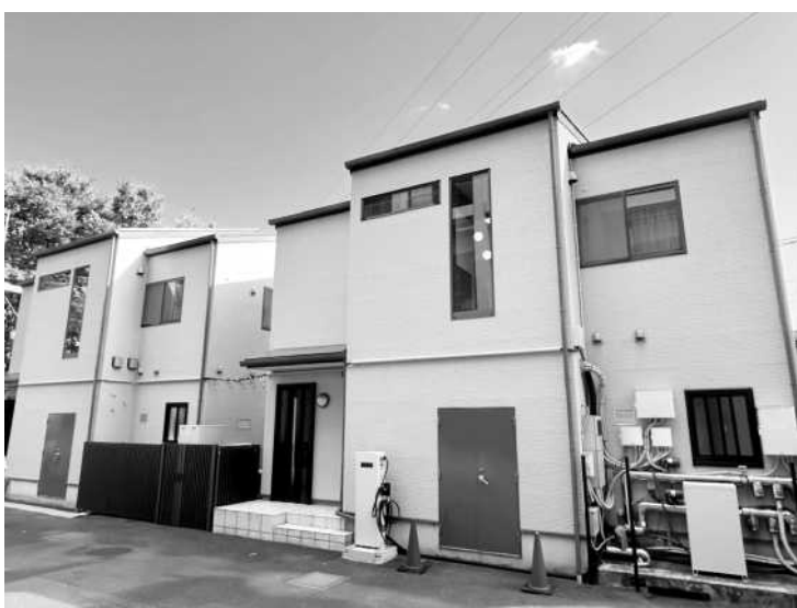
断熱性能と空調方式が異なる実験用の木造住宅2棟で、エネルギー消費量と室内温熱環境を計測（LIXIL・東京電力エナジーパートナー＝横浜市鶴見区）
